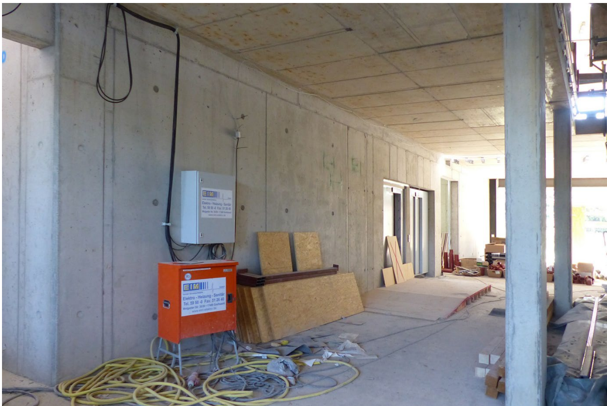
Blick vom Foyer auf Betonwand mit Aufzügen – Wandfläche gegenüber zukünftigem Bereich Empfang und Wartezone kein Kunststandort
