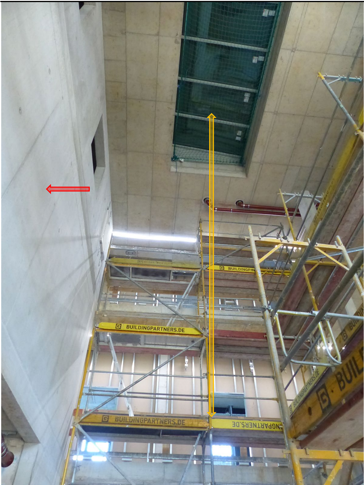
Betonwand im 1. / 2. Obergeschoss über zukünftigem Bereich Empfang/Wartezone im Erdgeschoss + Luftraum über Foyer bis Oberlicht – mögliche Kunststandorte ① + ②
