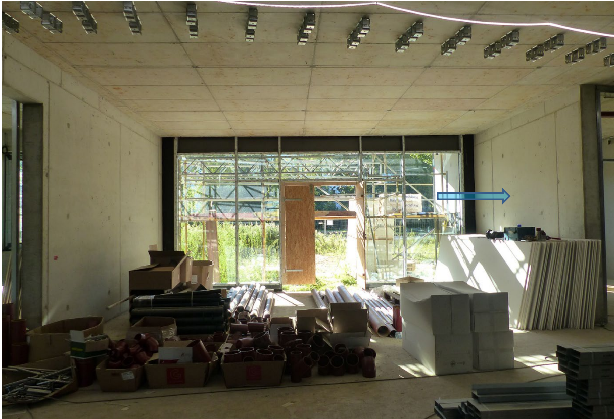
Blick vom Foyer in den zukünftigen Bereich Windfang Süd – Wandfläche rechts ist ein möglicher Kunststandort ③
